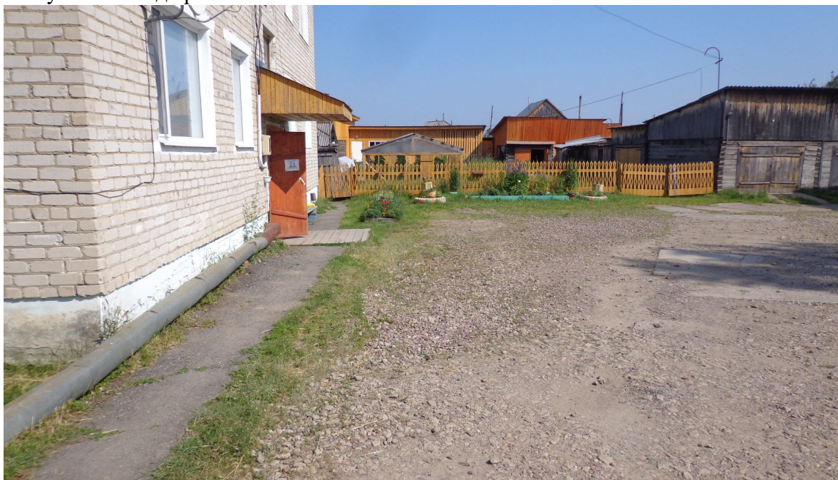
Хомутского 46 до ремонта
