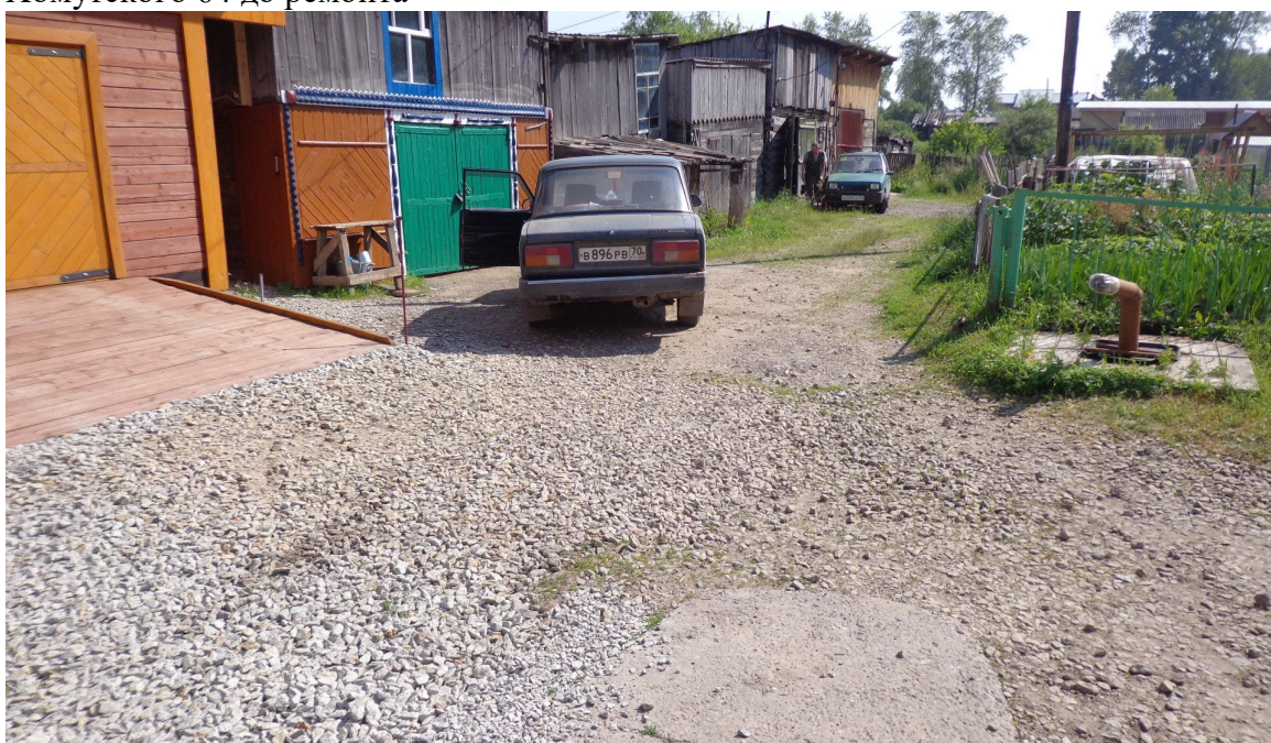
Хомутского 64 до ремонта
