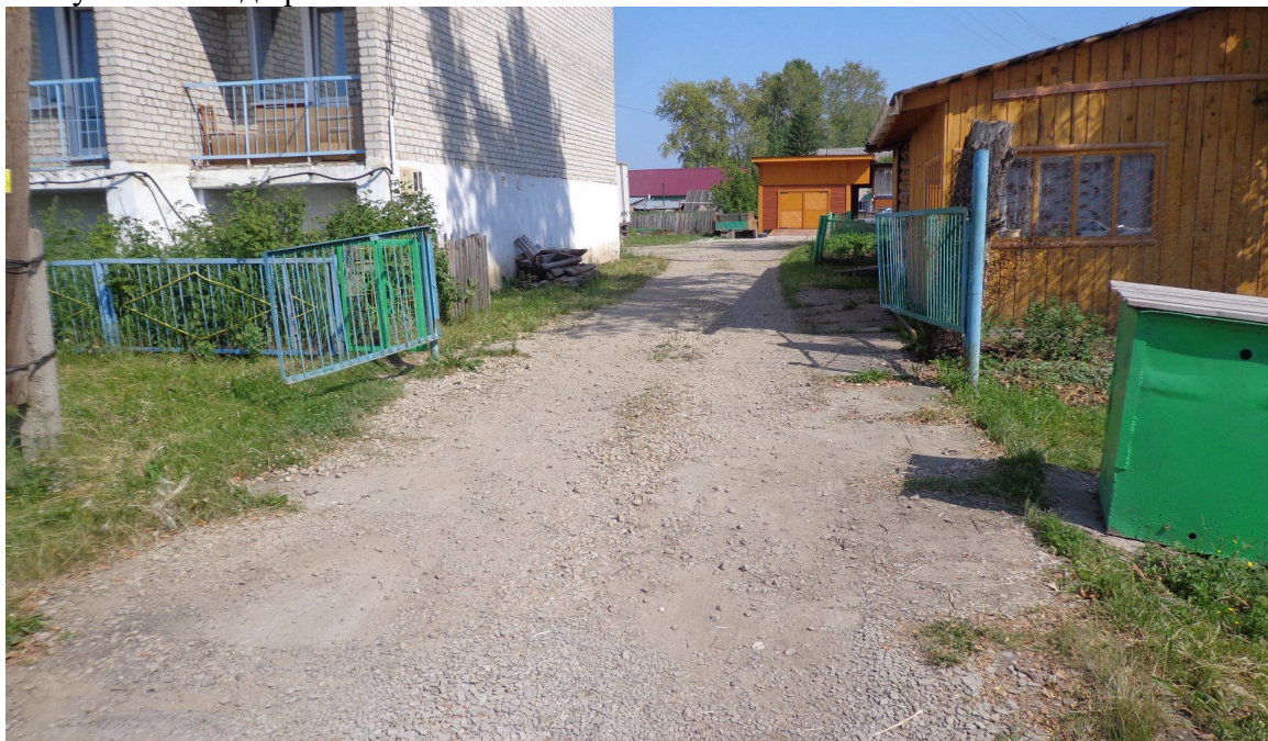
Хомутского 64 до ремонта
